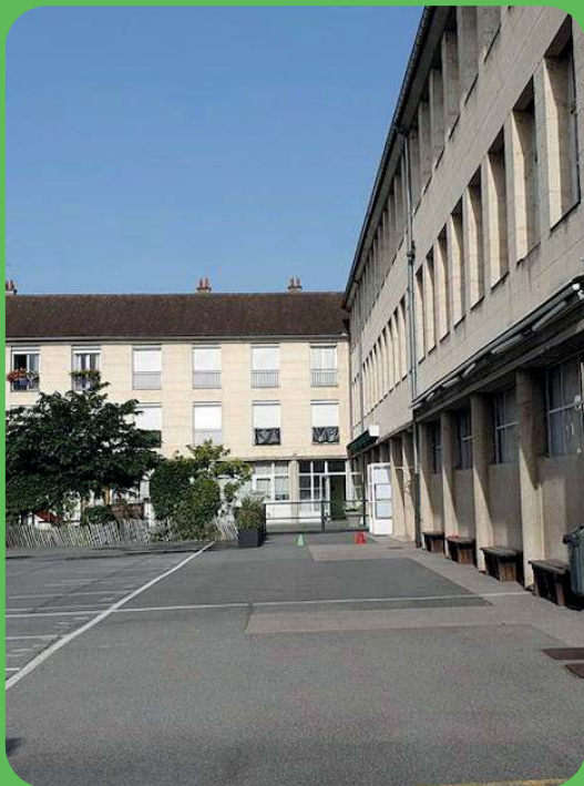
➡ Le Groupe Scolaire Séraphine Louis : fin du remplacement des menuiseries en plusieurs phases : maternelle côté rue en 2026
